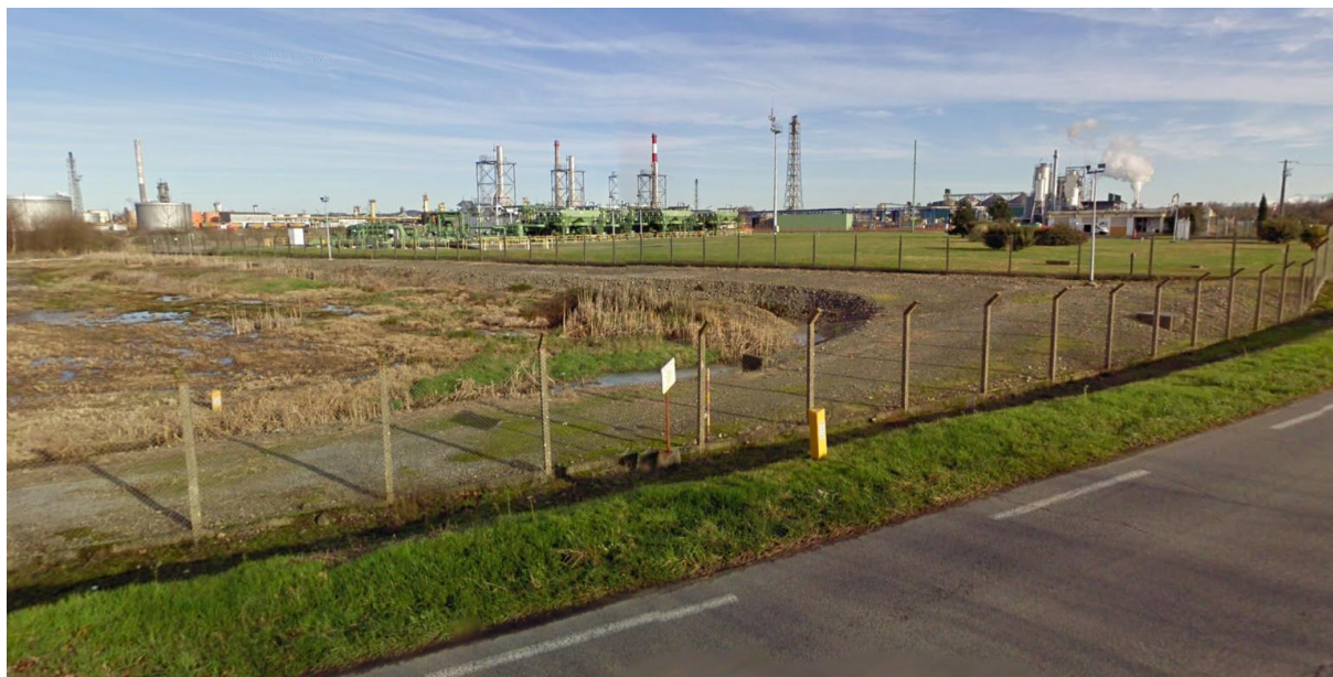
Figure 9 : Plateforme industrielle de Lacq
